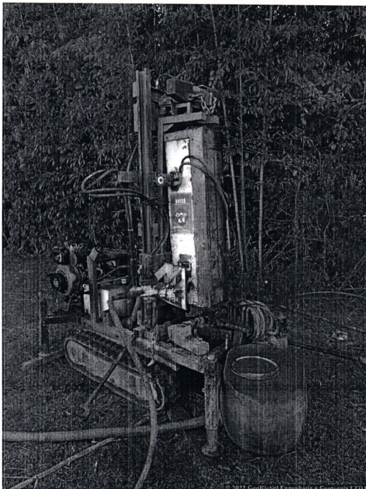
Foto 1 – FOTO 02: Execução SPT 03.
