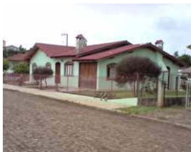
Habitação Alvenaria Padrão Médio
